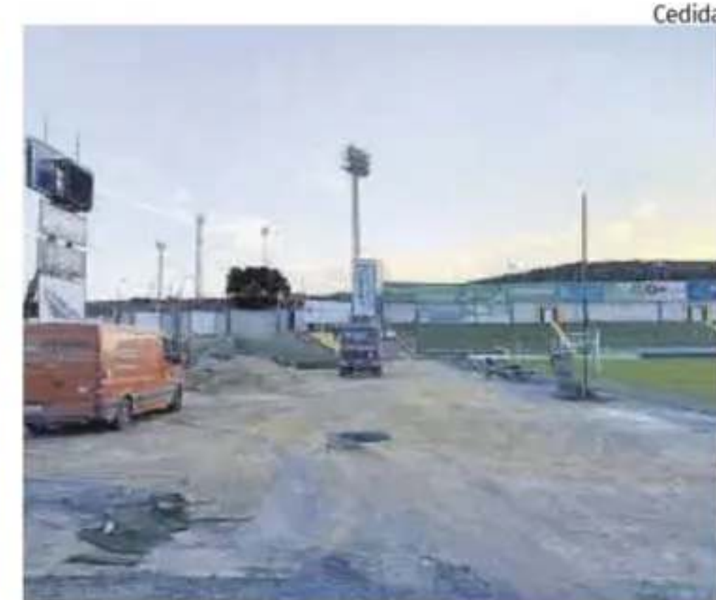
Trabajos para el estudio geotécnico en un fondo.
